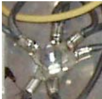
Un câblage de masse en étoile ...
